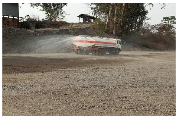
รูปที่ 2-15 การฉีดพรมน้ำบริเวณพื้นที่โครงการและเส้นทางขนส่ง
